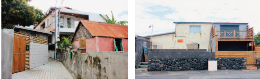
Figure 4 . Types de confrontations architecturales que l'on peut retrouver à Terre-Sainte. M. MALSAN, 2019
