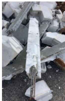
Protection des bétons : Chantier de démolition d'un frigo industriel dans le Nord Isère (2019), les ossatures en béton armé sont incluses au mur par l'intermédiaire du coffrage perdu qui fait office d'isolation thermique partielle.
