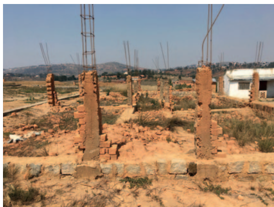
Démontage de la construction ordinaire
