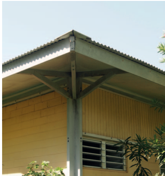
Ill. 5 : Dispositifs architecturaux du système EXN : « nacos », nœud d'assemblage cruciforme et mixité des matériaux, Mairie-Annexe de La Saline-les-Bains (2019) © Manon Scotto
