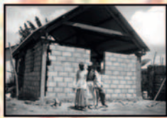
Remplissage en parpaings
