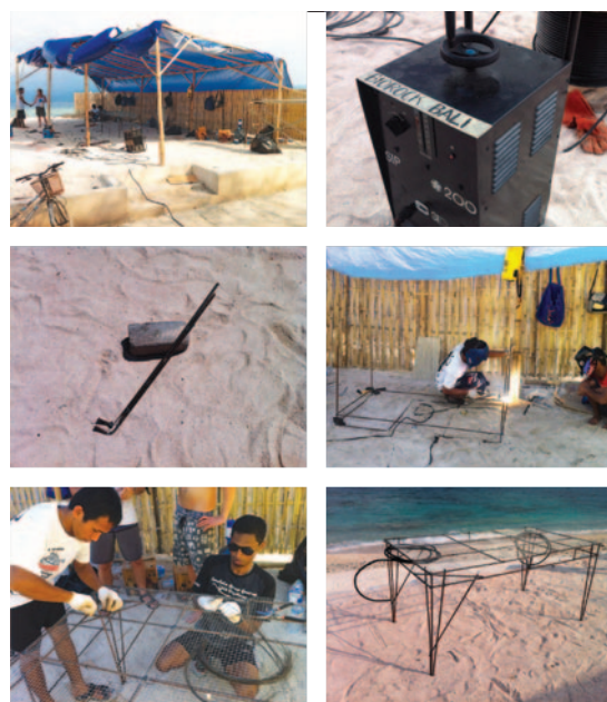
Atelier de construction de récifs artificiels sur la plage de Gili Trawangan. Réalisation d'un squelette de table. Photos : David Enon 2012
