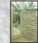
A gauche, une paroi avec porte finalisée. A droite, le treillis avec boue de terre et de paille.
