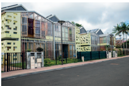
Opération : VUD Localisation : Le Guillaume Saint-Paul – 60 Logements © Thomas NOEL / IMROI
