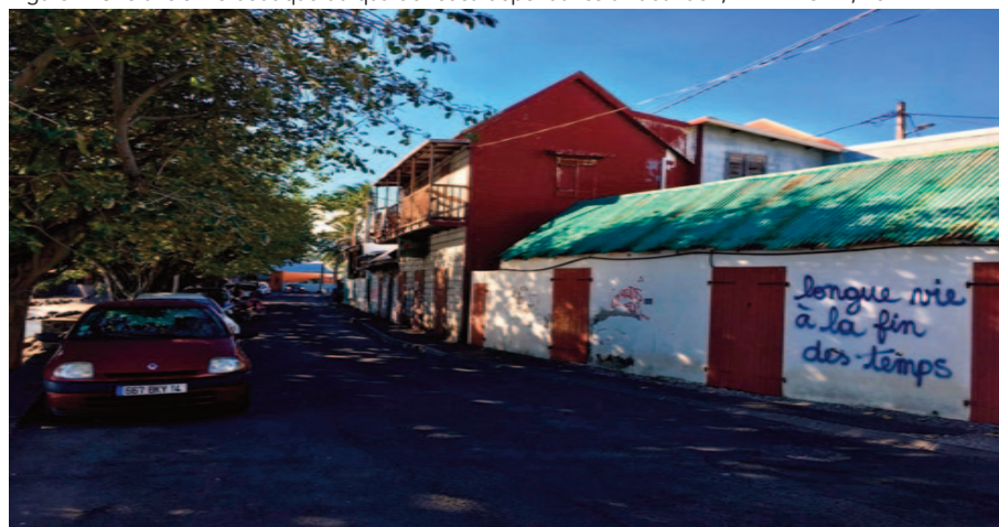
Figure 2. Une ancienne boutique du quartier et sa dépendance à l'abandon, M. MALSAN, 2017
