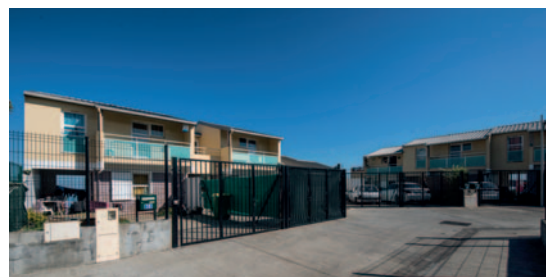
Opération : Ravine Daniel Localisation : Trois Bassins – 51 Logements © Thomas NOEL / IMROI
