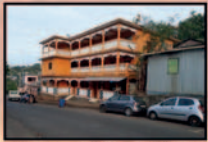
Les balustrades de chaque étage sont différentes. A noter le travail des linteaux. La maison à droite est réalisée en tôle. M'Espéré, 2019
