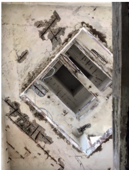
Sous face de dalle
