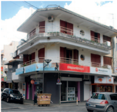
■ 4 - Immeuble Sarkis, rues Frébault et Barbès, 1948
