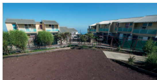
Opération : Ravine Daniel Localisation : Trois Bassins – 51 Logements © Thomas NOEL / IMROI
