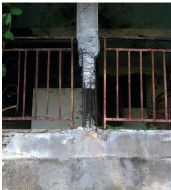
Construction ordinaire contemporaine
