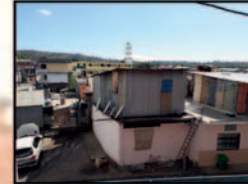
Le toit-terrace de cette maison accueille des cases en tôle en guise d'étage. Une échelle en permet l'accès. Kawéni, 2018
