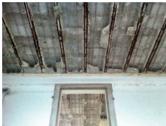
Armatures apparentes
