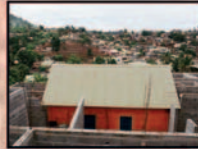
Extension en parpaing d'une « case SIM », 2004
